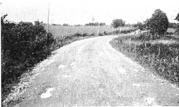
Fig. 7. Typiske bilhuller.
