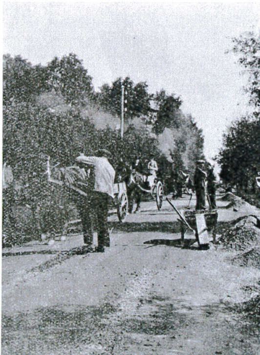
Fig. 9. Overflatebehandling av veien Berg—Fredrikshald. Utbedring av feil sommeren 1924. I 4.0 bredde derefter anbragt et asfaltbelæg ca. 2.0 l pr m 2 .
