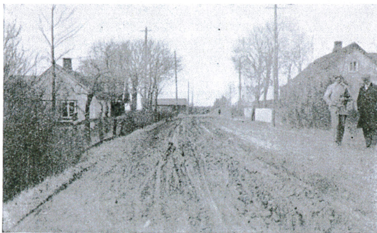
Fig. 12. Hovedveien gjennom Rygge (grusvei) under tæleløsningen 1924.
