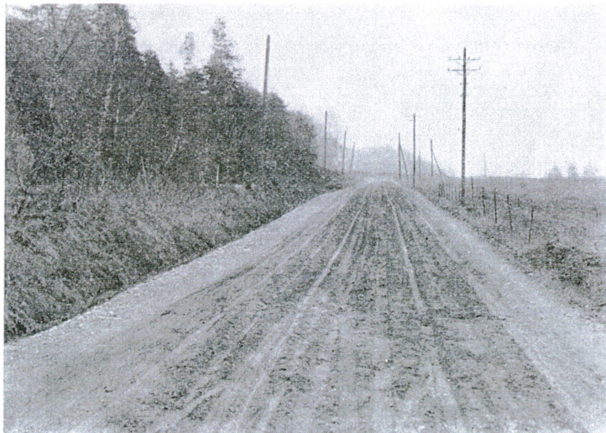
Fig. 2. Pukvei med dype hjulspor efter hestekjøretøier.
